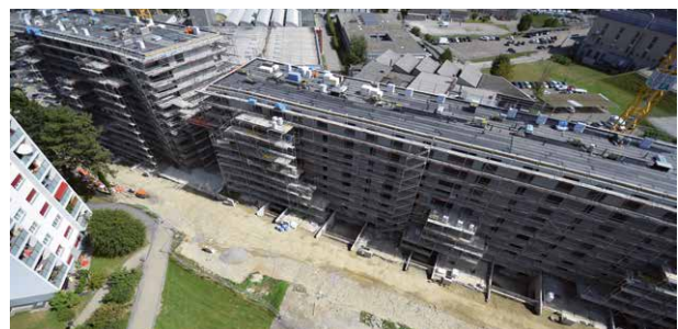
Freiburg, Route de la Glâne 15-17, Entwicklung der Bauarbeiten 2017–2018
